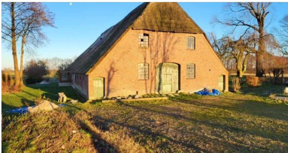
Toreinfahrt Hintere Ansicht So
