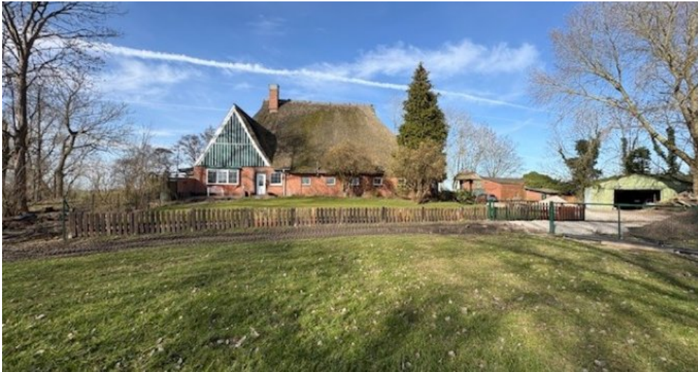
Erste Seite Exposé Außenbereich Rehweg
