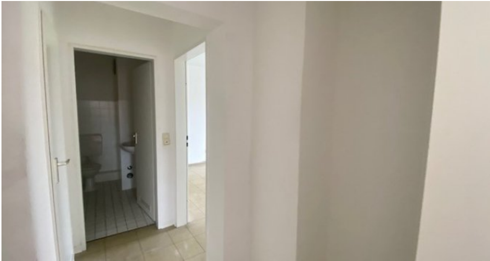
Kanal 11 2. Ansicht Flur
